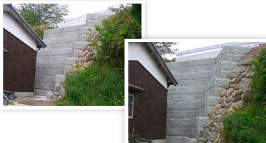
**壁高6.0mx延長6.0m 通学路の災害復旧工事**
