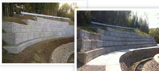
**壁高3～8mx延長50m 直線曲線混在5分勾配砂防工事**
