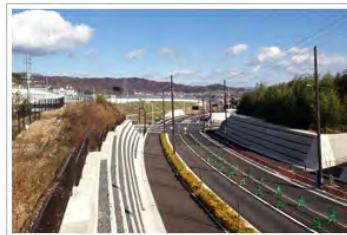
道路両側に敷設された箱型擁壁
