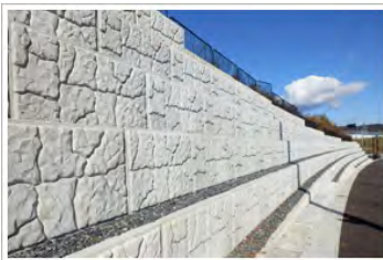
景観にマッチした箱型擁壁
