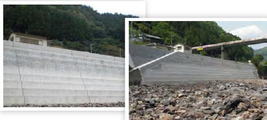
平成23年度の災害復旧にて使用していただきました。大型ブロックとの比較検討でしたが、当初設計で壁高11mあり道路側への掘削影響範囲と支持地盤があまり良くなく少しでも反力を軽減したいとのことで箱型擁壁が採用になりました。河川での使用でしたので擁壁前面に保護コンを施工しています。
