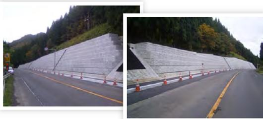
道路改良で歩道設置工事でした。当初見通しの悪い道路でしたが、箱型擁壁を設置することで歩道設置するのみではなく、見通しを良くすることもでき見栄えの良い現場となりました。切土という事もあり、箱型擁壁を採用する条件が整った現場でした。
