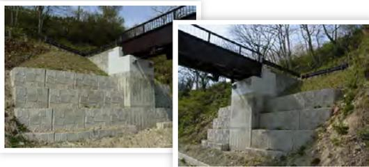
災害復旧の現場でした。当初、箱型擁壁と大型ブロックとの比較がありましたが、施工性の良い箱型擁壁を採用していただきました。実際の現場でも施工性の速さで災害復旧現場に御協力できたかと思えます。
