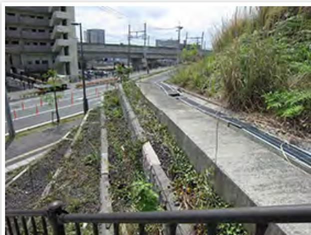
側溝のグレーチングが地震の衝撃により外れるが壁体にズレは無い。
