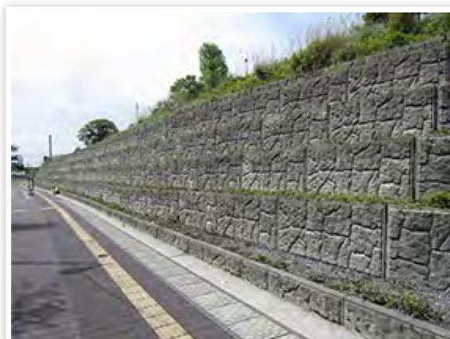
天端コン及び側溝に破損が見られる。一部箱体に若干の変位は見られる。擁壁の機能は維持している。
