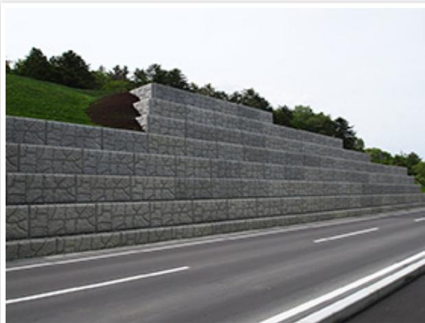
**排水性能に優れた箱型擁壁が採用されました。 壁高9m\*延長62m**
