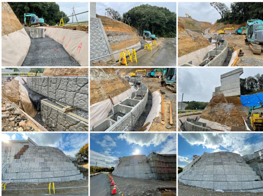
施工業者の方で現場の状況を精査され、計画より壁高を高くする必要がありました。現場で使用する盛土の土質試験を行い、再検討を行い、そのまま箱型擁壁を積み積み上げ施工することができました。
